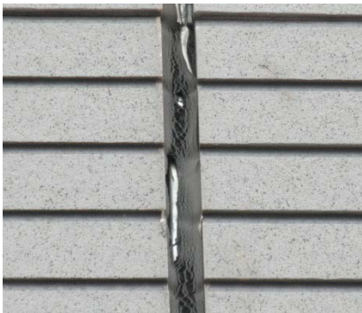
塗装メンテナンス=失敗例(左:目地深さ不足目地シール切れ 中:吸水のはくり 右:直張り塗膜のフクレ)
