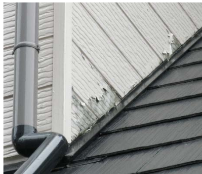
塗装メンテナンス=失敗例(左:目地深さ不足目地シール切れ 中:吸水のはくり 右:直張り塗膜のフクレ)
