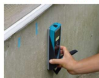
基礎配筋の調査
