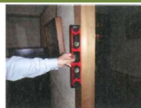
水平器による柱の傾きの計測
